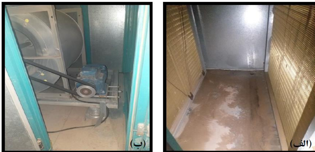
شکل ۱۰- هواساز بخش اورژانس و آزمایشگاه بیمارستان ولی عصر (عج): الف- تخلیه آب کندانس در سینی درین مابین کویل‌ها و ب- عدم وجود آب کندانس در محفظه موتور و فن.
