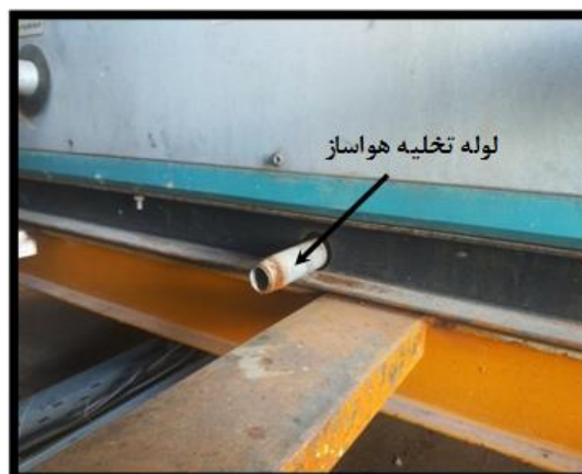
شکل ۱۱- عدم اجرای سیفون بر روی لوله تخلیه هواسازهای بیمارستان ولی عصر (عج).
