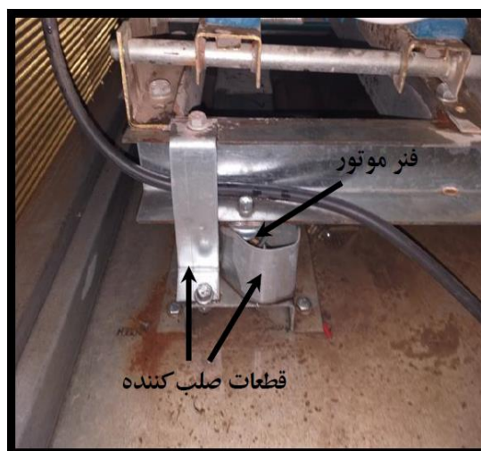
شکل ۱۷- قطعات صلب کننده سیستم فنربندی موتور هواسازهای بیمارستان ولی عصر (عج).
