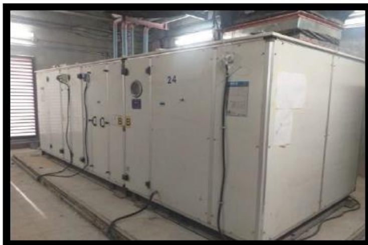
شکل ۲- هواساز بخش بستری بیمارستان ولی عصر (عج) با مقدار هوادهی 13400 سی اف ام.
