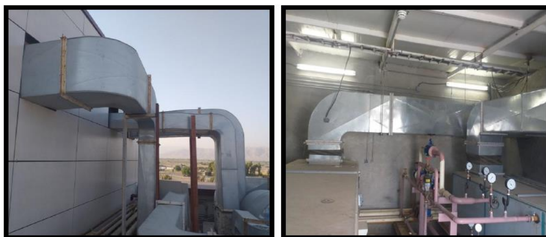
شکل ۴- عدم عایق کاری کانال رفت هواساز اتاق سوختگی و تجدید حیات قلبی بیمارستان ولی عصر (عج).
