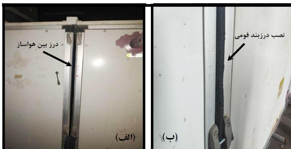
شکل ۱۵- هواساز بخش ICU بیمارستان ولی عصر (عج): الف- وجود درز بین هواساز که منجر به عدم عملکرد مطلوب سرمایشی هواساز شده است. ب- نصب درزبند فومی بر روی هواساز و کاهش دمای رفت به ۲۰/۲ درجه سانتی‌گراد.
