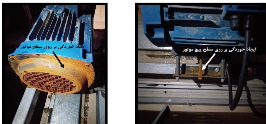
شکل ۹- ایجاد خوردگی بر روی سطح موتور هواساز بخش بستری بیمارستان ولی عصر (عج) و ایجاد اصطکاک شدید به علت ورود ذرات آب به درون موتور.
