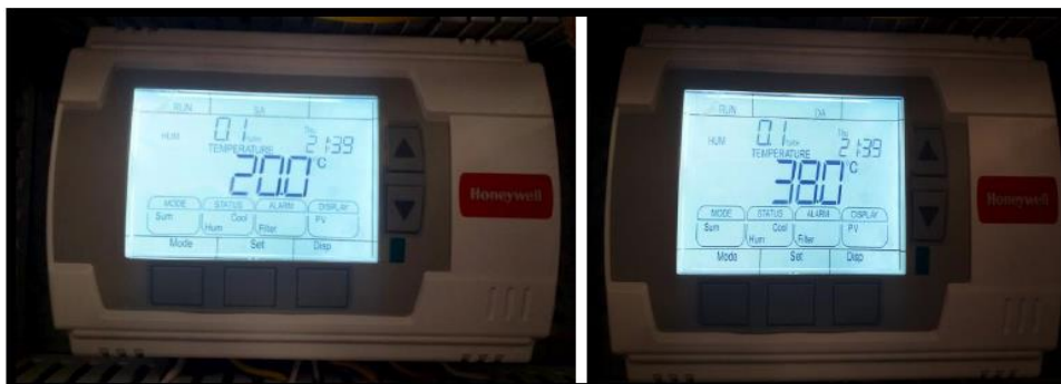
شکل ۶- دمای داخل و محوطه بیرون کانال هواساز بخش اتاق سوختگی و تجدید حیاط قلبی بیمارستان ولی عصر (عج).
