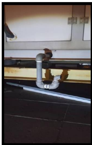
شکل ۱۴- اجرای سیفون بر روی لوله تخلیه سینی درین هواساز.
